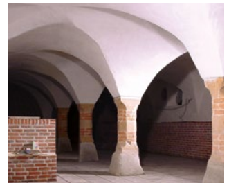
Das Mauerwerk dieser Gebäude wurde mit KÖSTER Sanierputz weiß instand gesetzt.
